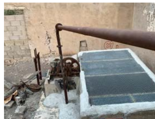
Fotografías del pozo. Estructura exterior sin techumbre y mal estado. Interior con motor original oxidada y en estado de abandono.
